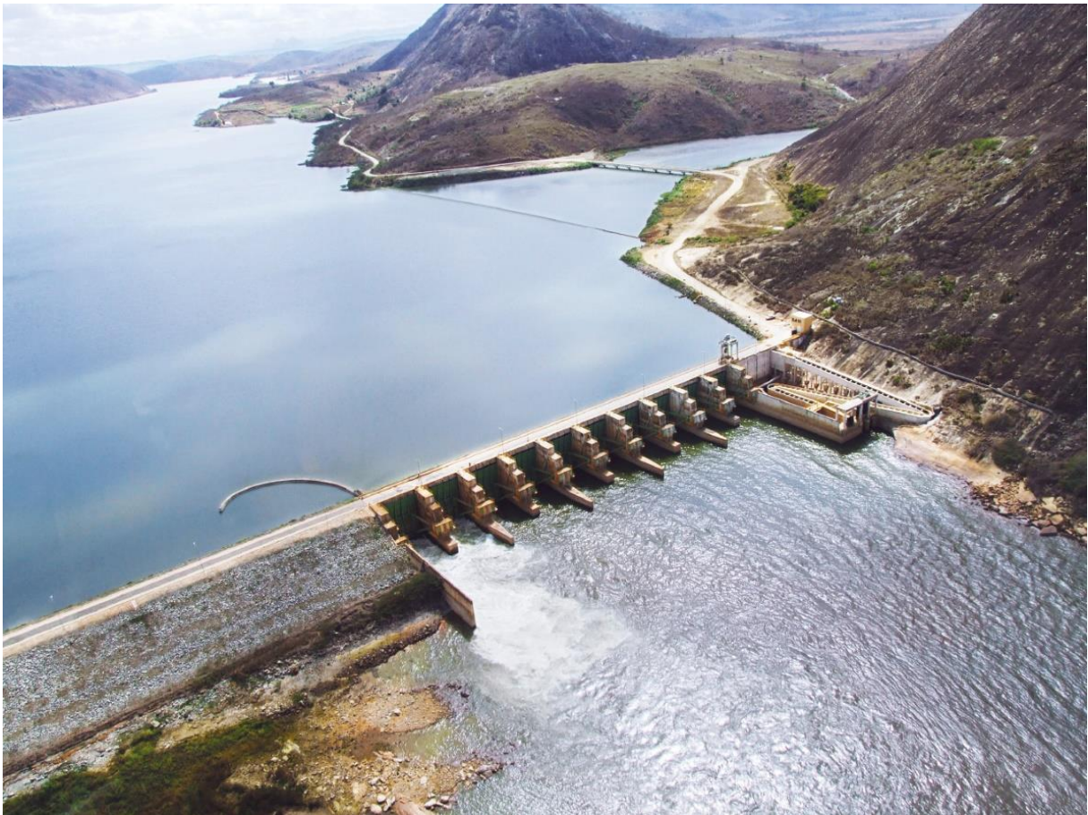
Figura 4.2 - Barragem Principal - Usina Hidrelétrica Eliezer Batista
